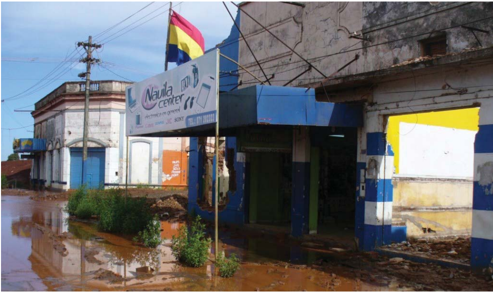
Figura 6: Inundación en la “zona baja” antes de su total demolición. Figura 7: Nuevo barrio comercial, Encarnación, 2010.
